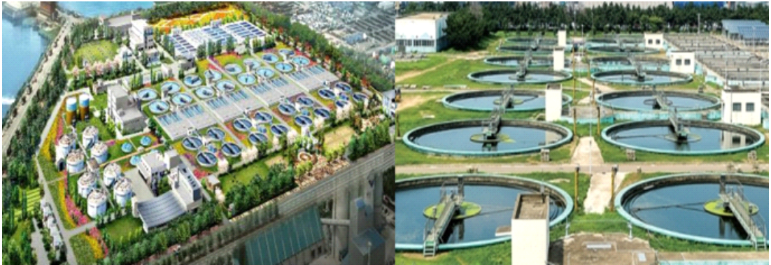
[그림 2-9] 인천광역시 가좌하수처리장
