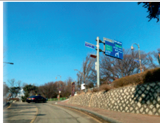
행주외동 쪽 통한 진입 도로 현황 (정비 前)
