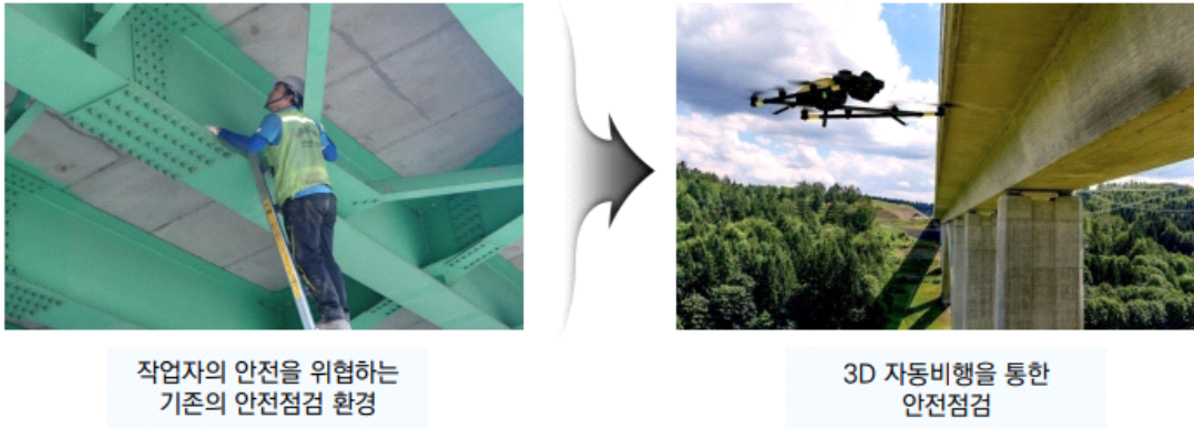
[그림 4-15] 드론을 이용한 안전 진단 서비스에 따른 작업자 위험성 감소
