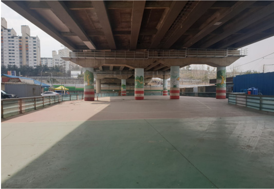
[그림 2-3] 백마교 고가도로 하부공간 현장사진
