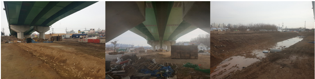
[그림 2-9] 토당-원당 국도대체우회도로 원당대교 하부공간 현장사진
